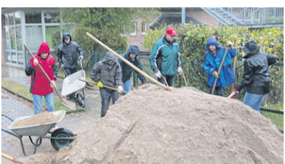
Hess. Oldendorf: KiTa St. Marien 11 t neuer Sand wurden im strömenden Regen mit Schubkarren vom Parkplatz in den Sandkasten im Außenbereich gefahren
